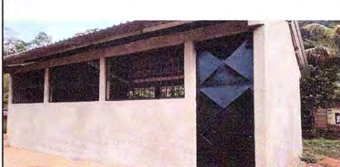
Foto 6: Rehabilitacion de aula finalizada.
