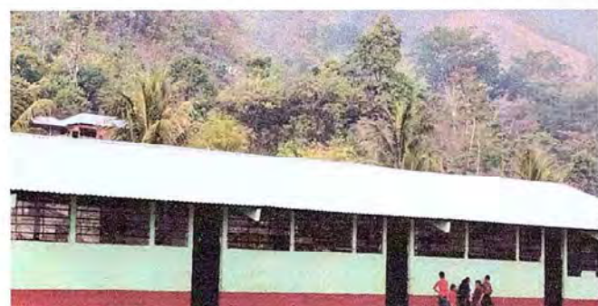
Foto 3 : Nuevo entechado finalizado de la escuela.
