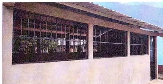
Foto 2: Vista frontal de rehabilitacion de aula.
