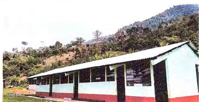
Foto 5: Estructura de entechado de escuela finalizado.
