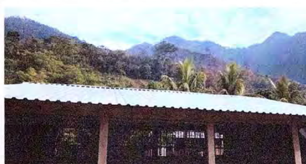
Foto 4: Estructura de entechado de aula rehailitada.
